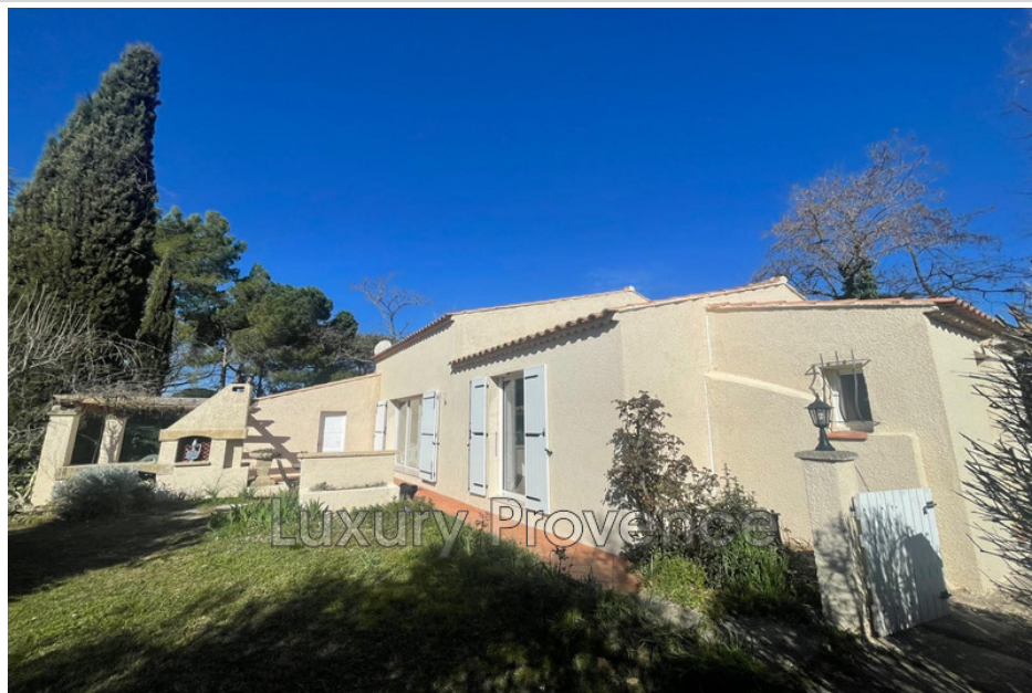
House T25013 Pourrières
